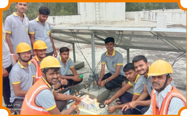
बंगलोर सोलर इन्स्टॉलेशन प्रशिक्षण घेताना बी. व्होक. रिन्यूएबल एनर्जी टेक्नॉलॉजी अँड मॅनेजमेण्टचे विद्यार्थी.
